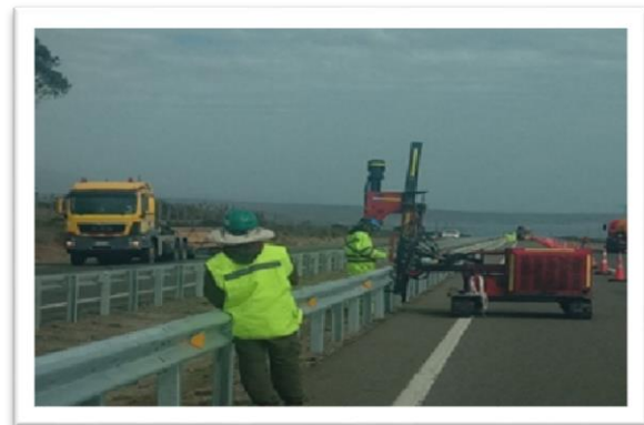
Foto 2: Instalación barrera metálica tramo I, sector interurbano.
