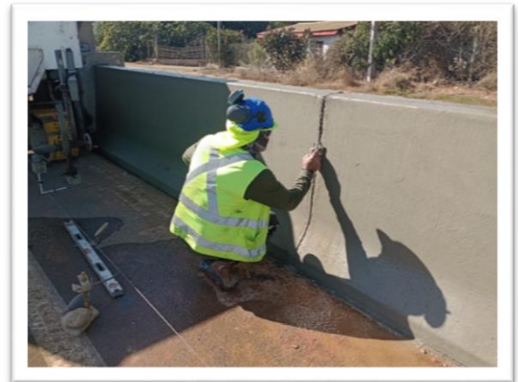
Foto 1: Ruta 5, fabricación barrera hormigón, tramo I, Sector interurbano, km 264.
