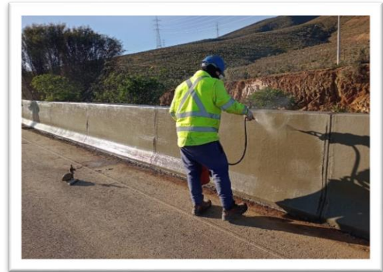
Foto 3: Trabajos de recambio de barrera de hormigón, sector interurbano.
