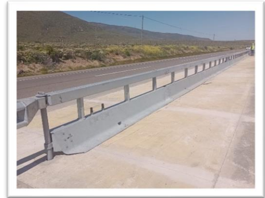
Foto 3: Km. 256, Instalación de Transfer, sector interurbano.
