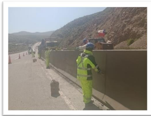
Foto 1: Ruta 5, Km 317, Trabajos de construcción de barrera de hormigón, sector interurbano.
