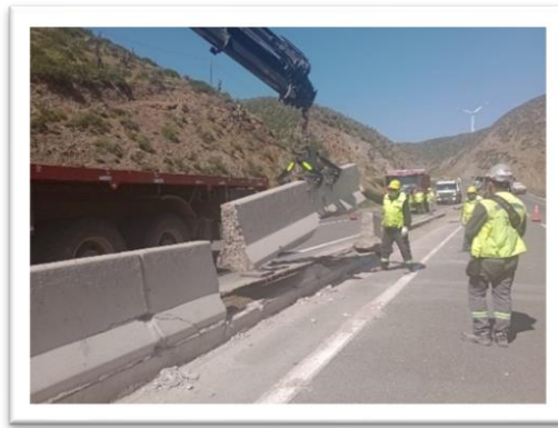
Foto 2: Ruta 5, Km 318, Retiro Barrera de Hormigón, sector interurbano.
