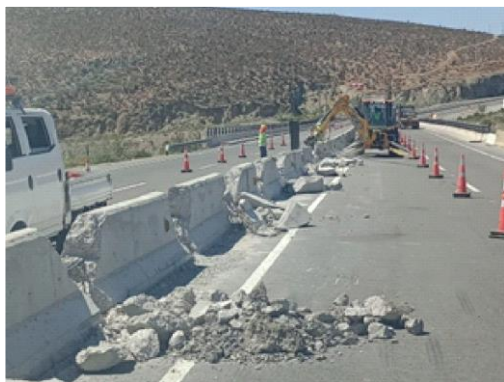
Foto 2: Ruta 5, Sector interurbano, trabajos de Demolición de barreras de hormigón.
