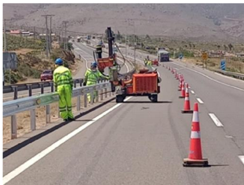
Foto 1: Ruta 5, Sector Interurbano, trabajos de corrección de barrera de metálicas con equipo de hincado.
