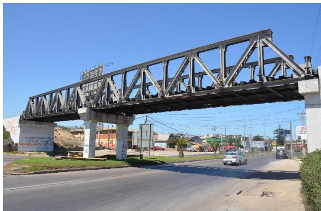
Paso Superior FFCC Sector Coquimbo
