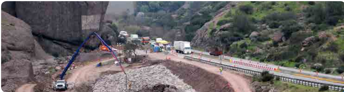
> Construcción Viaducto Las Chilcas
