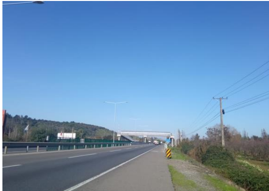
Pasarela PUTAGÁN (Km 291.810)
