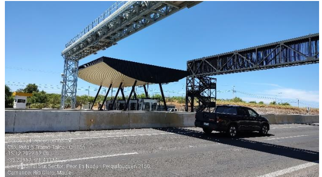
Plataforma del Sistema de Cobro Mixto Peaje Río Claro (Km 220,330).
