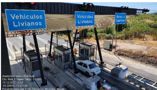
Operación de Cobro manual en Peaje Río Claro (km 220,330) lado oriente.
