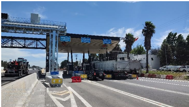
Operación Cobro manual en Peaje Retiro (km 322,560) lado poniente
