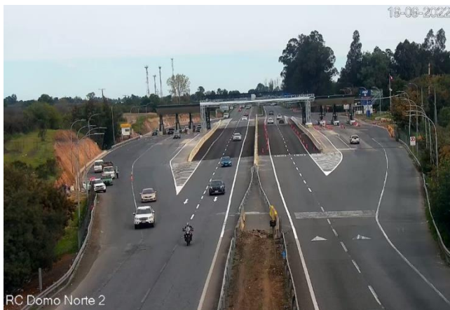
Operación de Cobro Electrónico MLFF en Peaje Río Claro (km 220,330)
