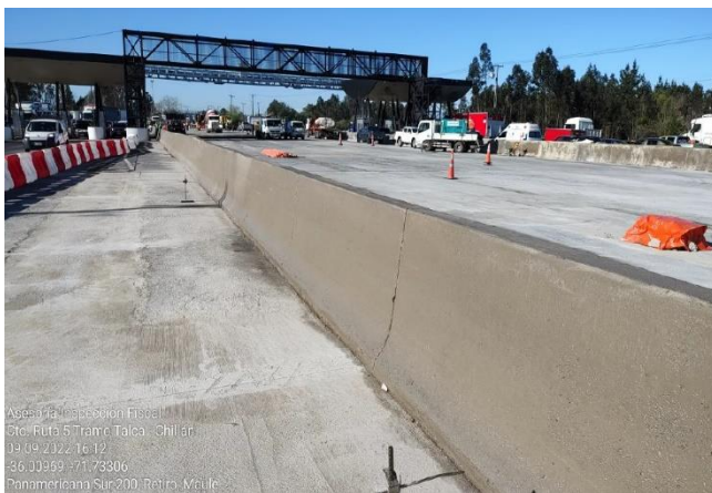
Trabajos por Obras Sistema de Cobro Mixto Peaje Retiro (Km 322,560)
