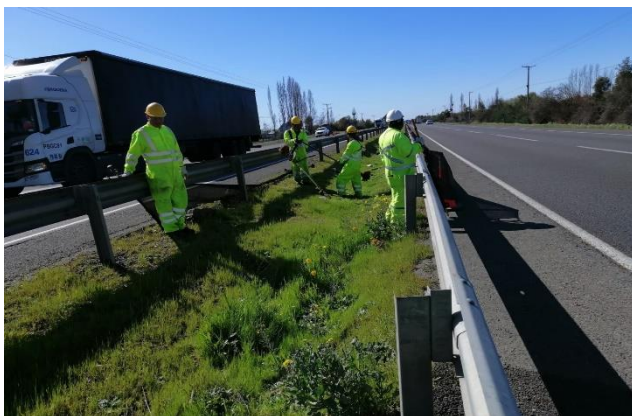
Km. 362, sector mediana, trabajos de limpieza y roce de la Faja.
