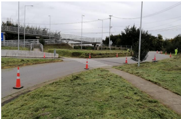
Pasarela Santa Monica Km. 346,600 lado oriente, trabajos de limpieza y roce.
