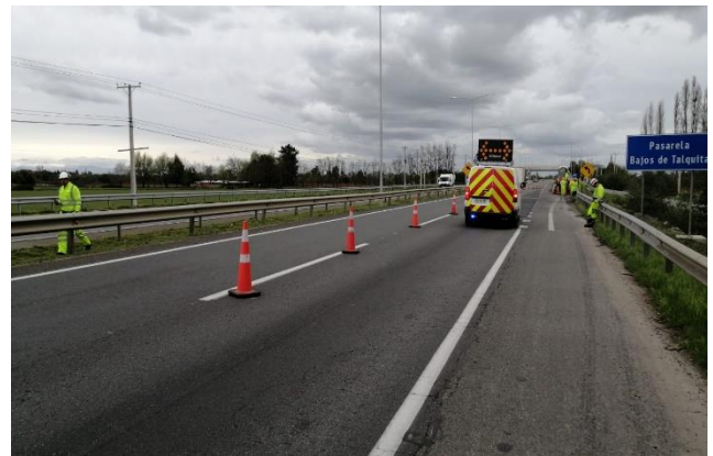
Sector Pasarela Bajos de Talquita Km. 351.625, Trabajos de limpieza y roce de la Faja.
