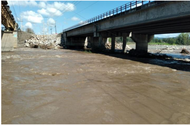
Puente Lircay N°01 Km. 248.556, vista hacia estribo.
