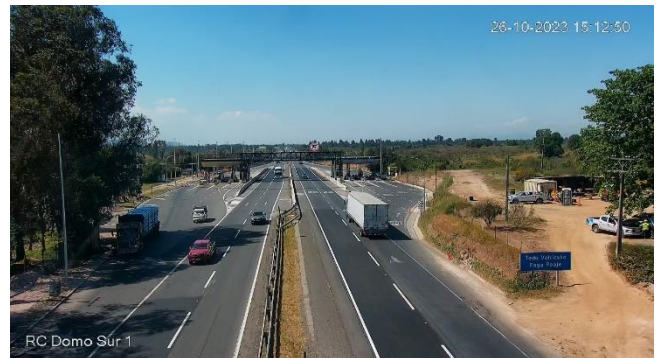
Vista del Peaje Troncal de Río Claro Km. 220,330.
