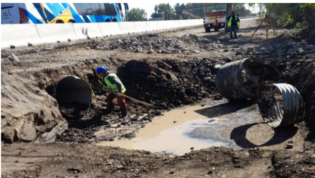
Trabajos en instalación de Obra de Arte peaje Troncal de Retiro Km. 322,400.
