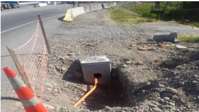
Trabajos en instalación de cámaras de alumbrado peaje Troncal de Retiro Km. 322,400.
