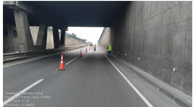
Levantamiento topográfico sector Soterrado de San Carlos km 375,998.
