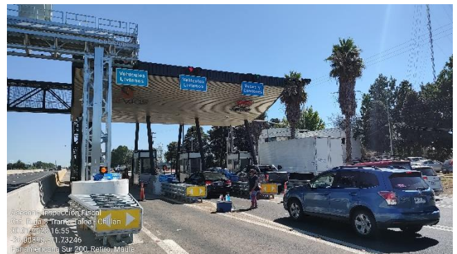
Operación de Cobro manual en Peaje Retiro (km 322,560) lado poniente.
