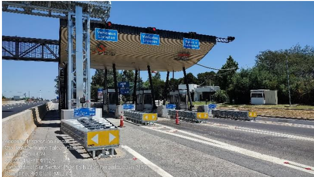
Operación Cobro manual en Peaje Río Claro (km 220,330) lado poniente
