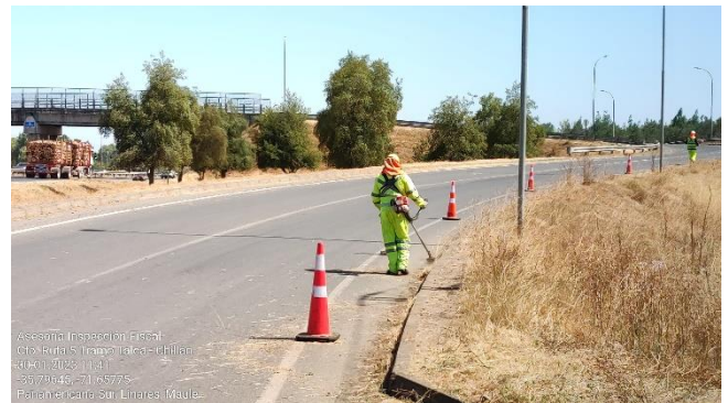
Trabajos de Limpieza de la Faja (Km 295,620).
