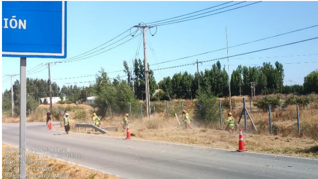
Trabajos de limpieza de faja (km 275,540)
