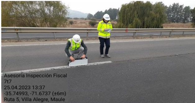
Asesoría Inspección Fiscal 717 25.04.2023 13:37 -35.74993, -71.6737 (±6m) Ruta 5, Villa Alegre, Maule Control de retro reflectancia (km 290,210) Eje pista oriente.
