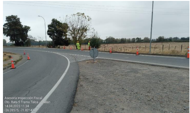
Asesoría Inspección Fiscal Cto. Ruta 5 Tramo Talca - Chillán 14.04.2023 11:34 -36.28575, -71.82142 Trabajos de roce y limpieza de la faja Km. 355,860 lado oriente.
