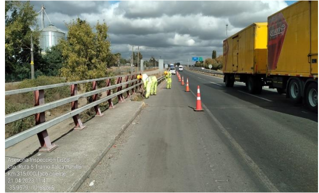
Asesoría Inspección Fiscal Cto. Ruta 5 Tramo Talca - Chillán Km 315,000, lado oriente 21.04.2023 11:47 -35.9579, -71.69269 Trabajos de limpieza de bermas Km. 315,240 lado poniente.
