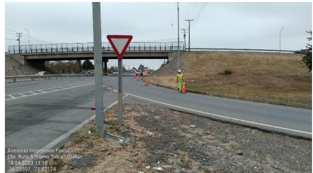
Asesoría Inspección Fiscal Cto. Ruta 5 Tramo Talca - Chillán 14.04.2023 11:18 -36.28597, -71.82124 Trabajos de roce y limpieza de la faja Km. 355,880 lado oriente.
