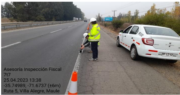
Asesoría Inspección Fiscal 717 25.04.2023 13:38 -35.74989, -71.6737 (±6m) Ruta 5, Villa Alegre, Maule Control de retro reflectancia (km 290,210) Línea continua berma lado oriente.
