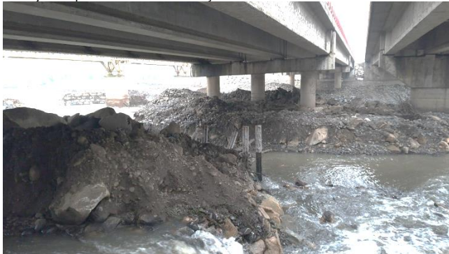
Trabajos de protección de la rivera y estribos.
