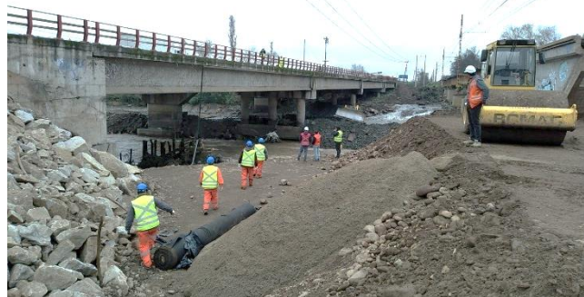
Trabajos de reconstitución del terraplén.
