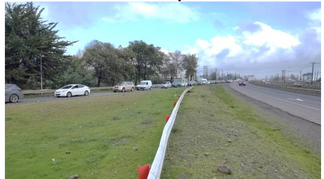
Vía de Acceso a Enlace Chillán Viejo Km. 406.430.
