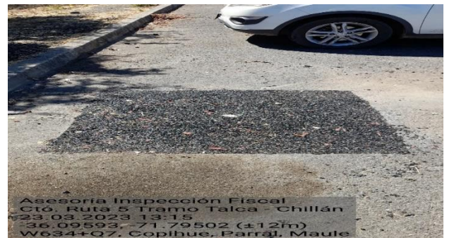
Trabajos de reparación de baches en frío sector Copihue.
