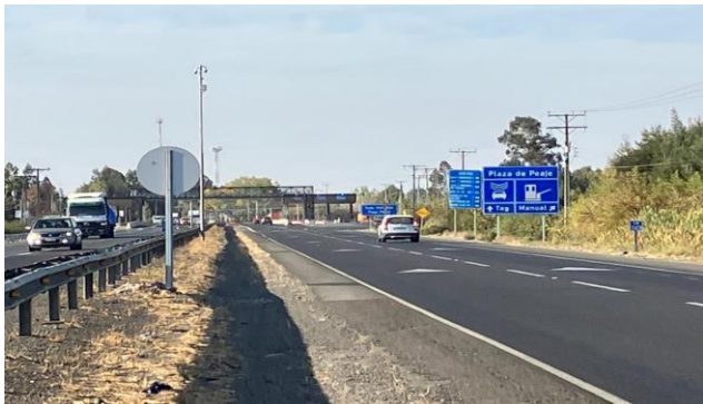
Panorámica funcionamiento Peaje Retiro (km 322,560,330) general.
