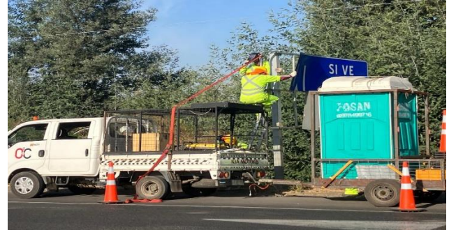
Reparación de Señal Vertical Km. 323,250 lado oriente.
