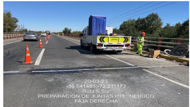
Trabajos de Reparación de Juntas Puente Nebuco Km 411,292, poniente.
