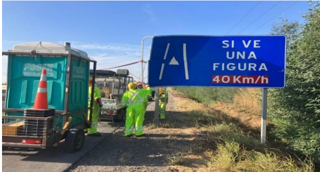
Reparación de Señal, lado oriente, km 323,250.
