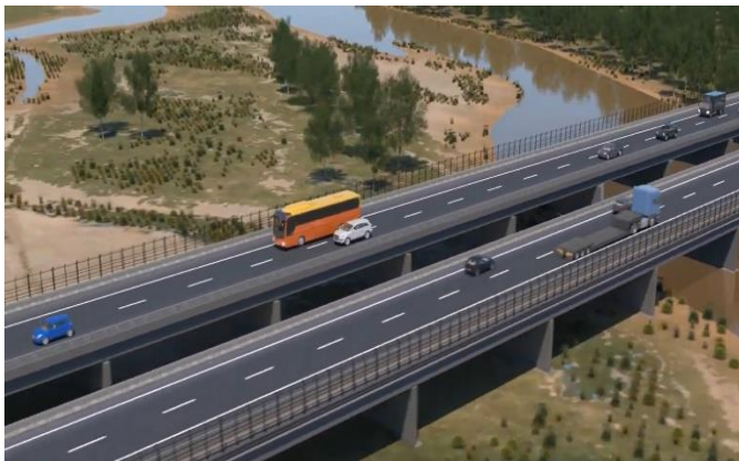
Nuevo puente sobre el Río Maule de 1,5 km de extensión
