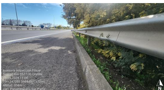
Dm 352.100 – Soleras Berma Oriente.
