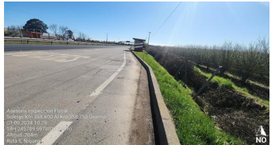
Dm 358.600 – Soleras Berma Oriente.
