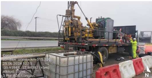
Trabajo Sondaaje, Km 315.320 Oriente.
