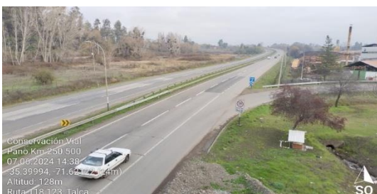
Demarcación Horizontal, Km 250.500, Poniente.
