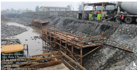
Mampostería, km 376,300 oriente.
