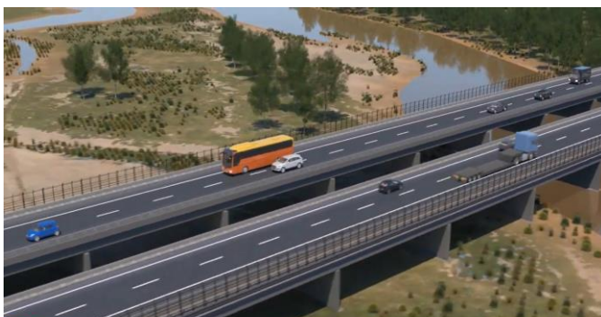
Nuevo puente sobre el Río Maule de 1,5 km de extensión
