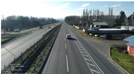
Dm 274.930 – Panorámica Sector Pasarela San Patricio.
