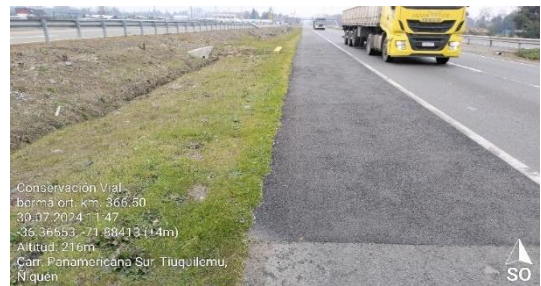
Dm 366.500 – Reparación Berma Oriente.
