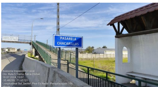
Señal vertical Km 259,000 Poniente
