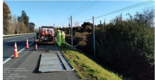
Mantenimiento Km 309,100 Poniente
