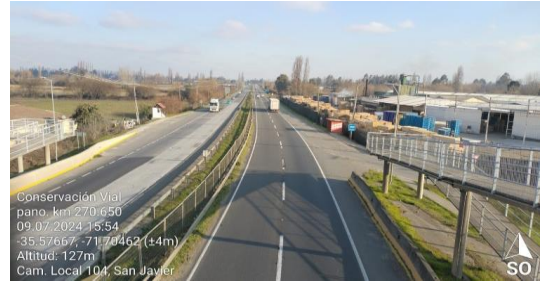
Panorámica km 270,650 Poniente
