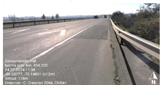
Dm 404,220 –Reparación Berma Oriente.
