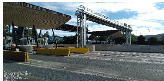
Vista 3, Plaza de Peaje Troncal Río Claro Km. 220,500.
