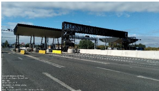
Vista 1, Plaza de Peaje Troncal Río Claro Km. 220,500.
