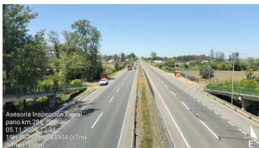
Dm 309.800 - Panorámica Pasarela La Finca.
