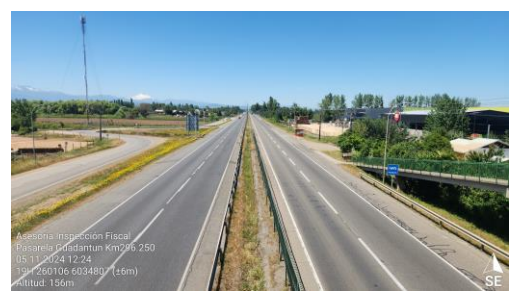
Dm 296.250 - Panorámica Pasarela Guadantun.
