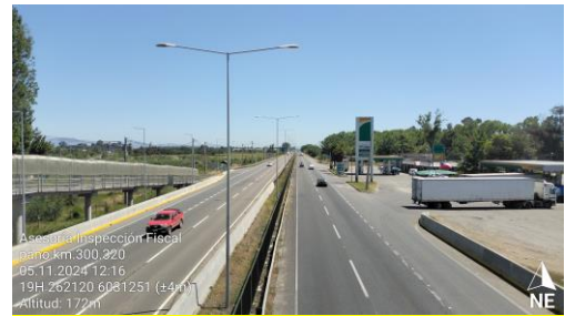
Dm 300.320 - Panorámica Pasarela Camino Real.
