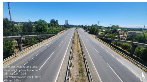
Dm 333.740 - Pasarela Copihue.
