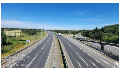
Dm 410.750 - Panorámica Pasarela Los Colihues.
