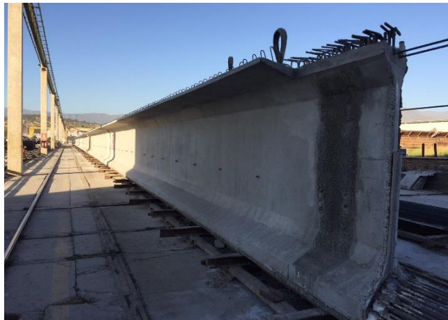
Puente Las Tinajas, en la foto fabricación de vigas pretensadas en la planta TITil de la empresa PREANSA
