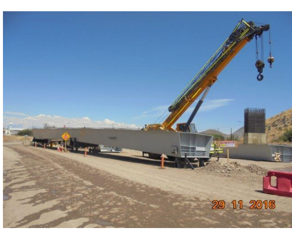
Viaducto de San Felipe, Se observa la llegada de tramos vigas de acero
