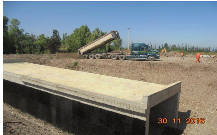
Se trabajó en 6 atravesos, en la foto Atravesio 7, Dm 29.963, terminado el hormigón se iniciaron los rellenos.
