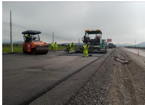
Concreto asfáltico capa intermedia, DM 90620 -91290
