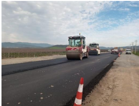
Concreto asfáltico capa intermedia, DM 84000
