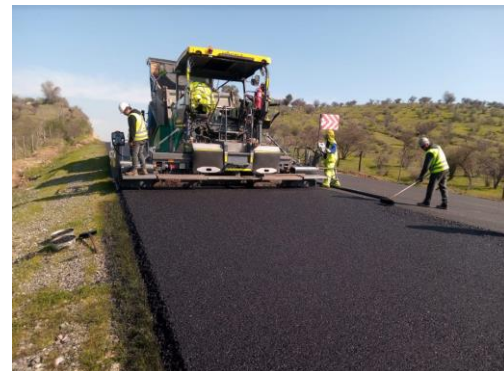
Concreto asfáltico capa intermedia, Variante Los Culenes
