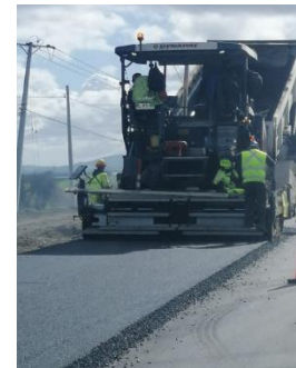
Colocación de Asfalto Dm 82.500 – 82.900, lado izquierdo
