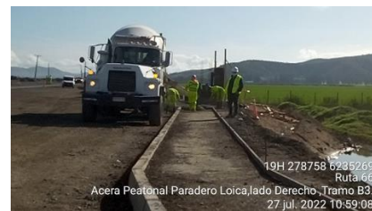
Construcción Aceras y Paradero N°21, DM 82.450, lado derecho
