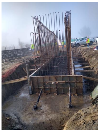
Enfierradura de Pilar y fundación de Pasarela, DM 98.077
