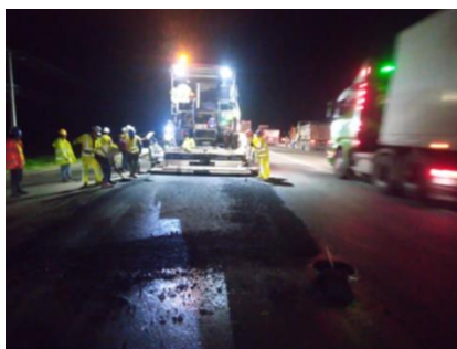
Colocación de pavimento desde el Dm 108.800 al 110.600
