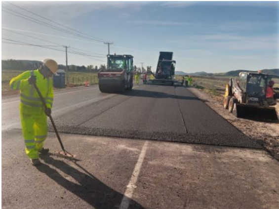
Concreto asfáltico de rodadura, DM 82.560-84.340
