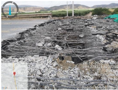
Demolición Puente La Cabaña, Dm 84.460
