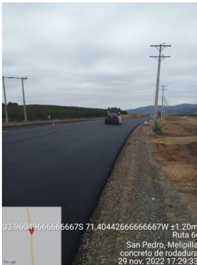
Concreto Asfáltico de Rodadura 86.900-90.100
