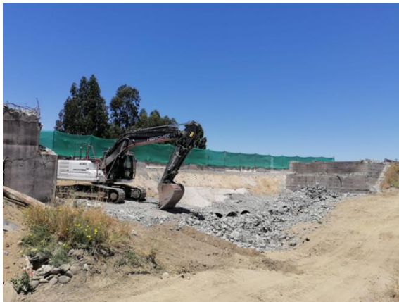
Demolición Puesto La Cabaña, Dm 84.460
