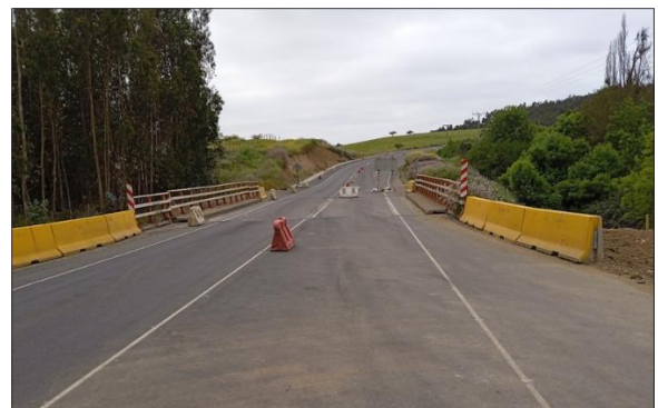
Dm 106.300 Tablero de Puente El Colo
