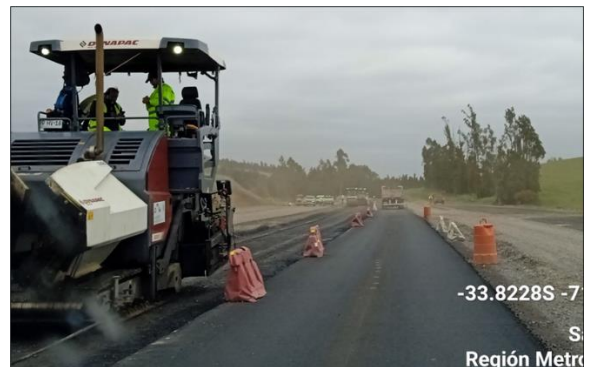
Dm 108.250 Faena de Pavimentación
