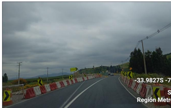
Dm 84.420 Entrada a Desvío de Puente La Cabaña
