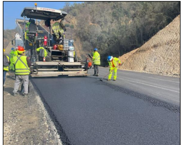
Concreto asfáltico rodadura Dm 73.960 al 74.440
