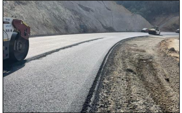
Concreto asfáltico rodadura Dm 73.960 al 74.440
