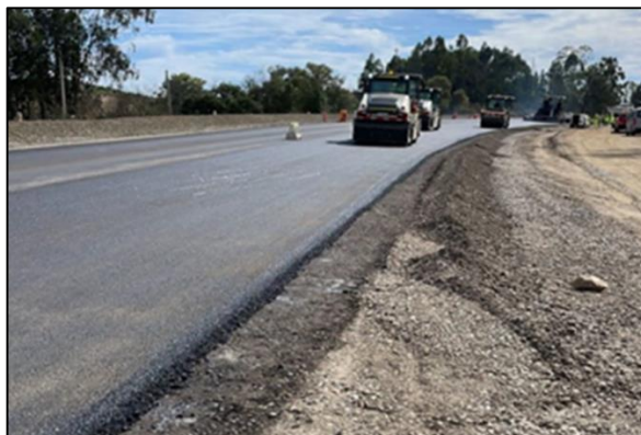
Concreto asfáltico capa intermedia Dm 112.340 – 112.900
