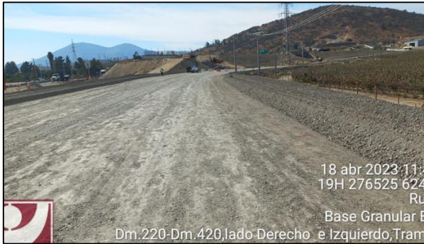
18 abr 2023 11:4 19H 276525 624 Ru Base Granular E Dm.220-Dm.420,lado Derecho e Izquierdo,Tram Base Granular PS Las Arañas Oriente Dm 92.542 Eje 40
