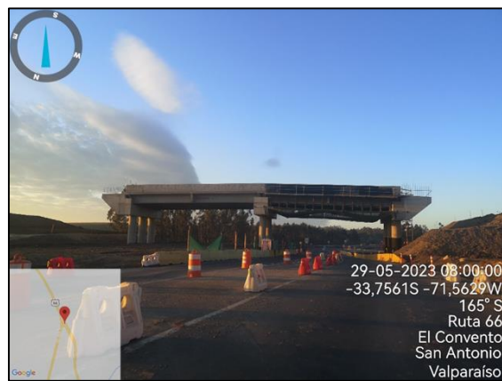
Encofrado Barreras de hormigón PI Rapel Dm 117.000
