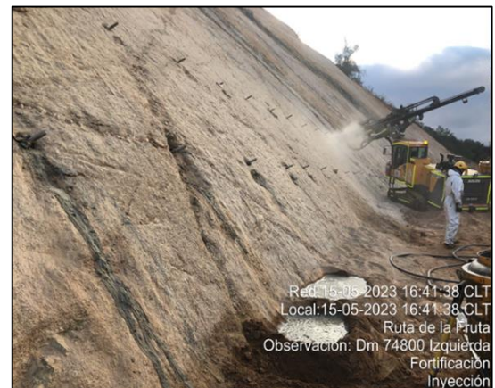
Sostenimiento de taludes Dm 74.800
