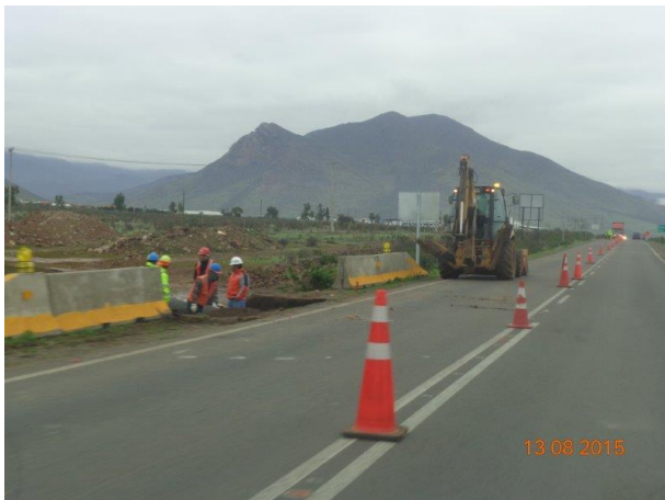
Trabajos Cajones Prefabricados
