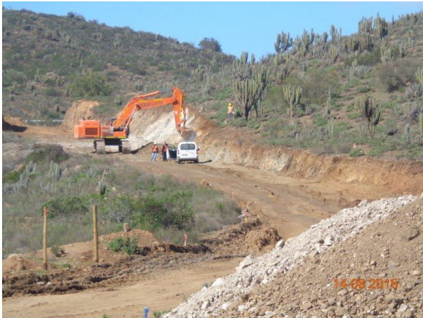
Excavacion en corte Sector El Totoral.
