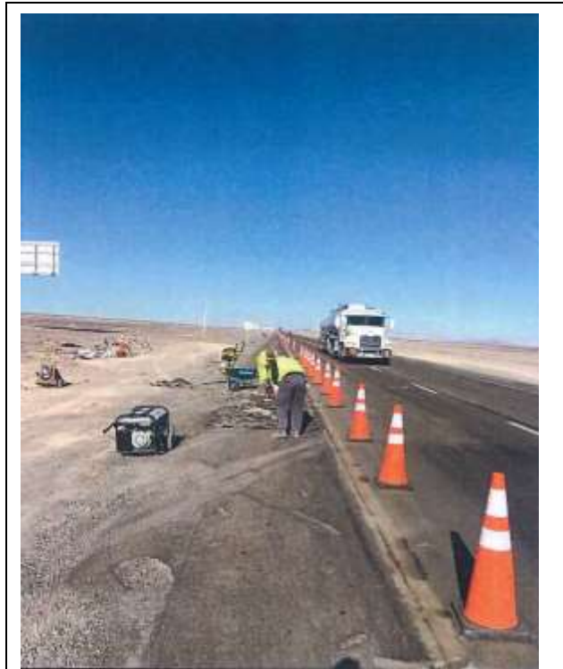
Trabajos en Baches (Sector A Ruta 25)
