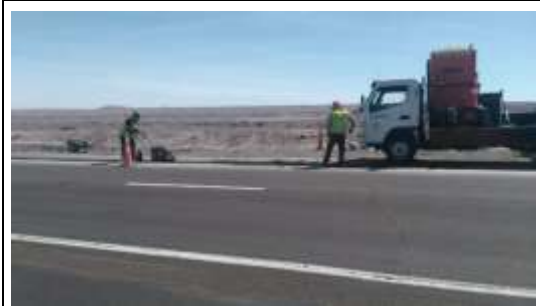
Vista de Trabajos de Reparación de Baches en Ruta 25 (Sector A)
