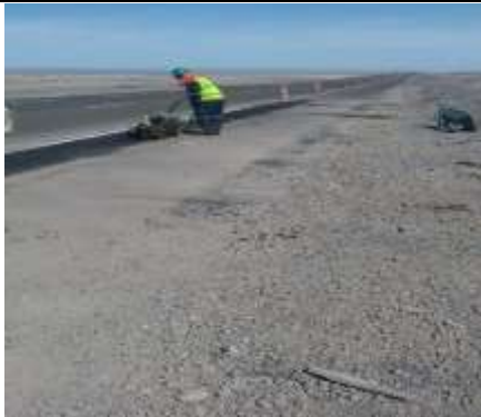
Vista de Trabajos de Reparación de Baches – Ruta 25 (Sector A)
