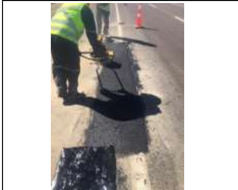
Vista de Trabajos de Reparación de Baches – Ruta 25 (Sector A)
