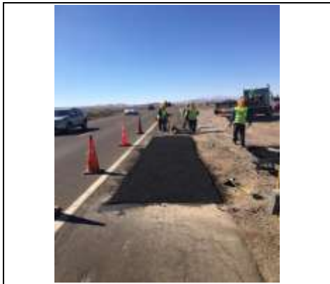
Vista de Trabajos de Reparación de Baches en Ruta 25 (Sector A)
