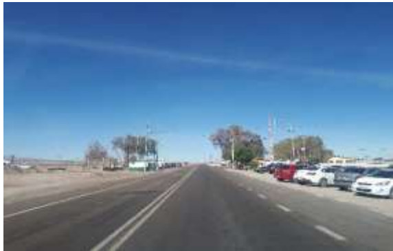
Vista de Instalación de Carabineros en Sector Acceso Sur a Calama - Dm. 108.300
