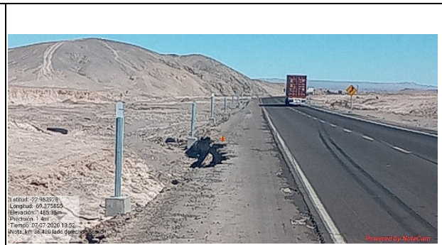
Foto N° 02 Señalización en Ruta 25
