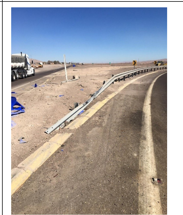
Foto N° 06 Vista de obs. en Ruta 25
