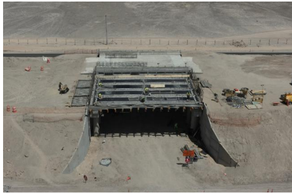
Foto N°03 PS Enlace Parque Industrial. Sector A
