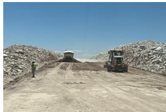
Foto N°06 Conformación de terraplén Km 22. Sector B
