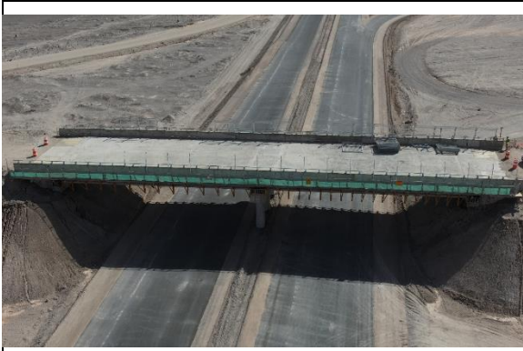
Foto N°01 Enlace Dupont. Sector A
