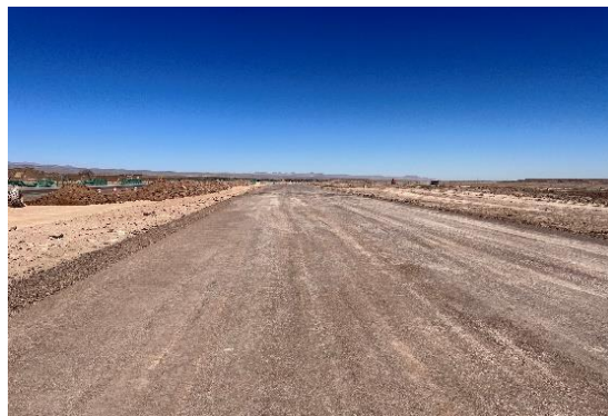
Foto N°05 Conformación de terraplén Km 20. Sector B.
