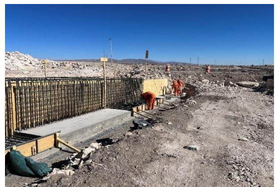
Foto N°06 Gasoducto EnorChile Km 20. Sector B.
