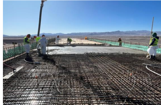
Foto N°02 PI Dupont. Hormigonado de losa. Sector A
