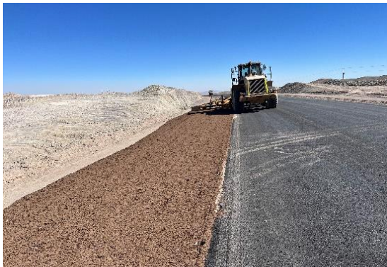
Foto N°03 Conformación berma interior Km 80. Sector A
