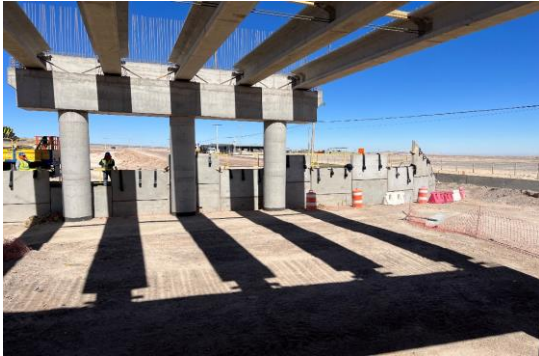
Foto N°01 PS Parque Industrial. Muro TEM. Sector A
