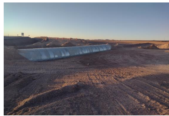
Foto N°04 Colocación protección tubería Agua Km 66. Sector A
