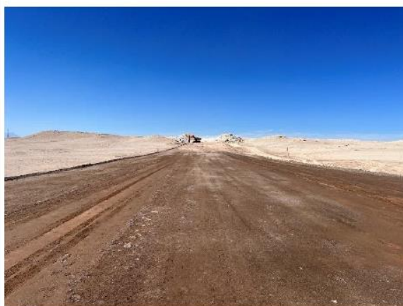
Foto N° 06 Conformación de terraplén Dm 20.000 sector B
