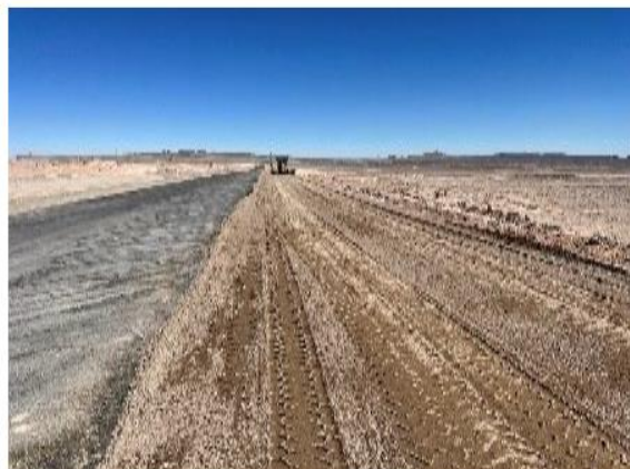
Foto N°2 Colocación de base granular Dm 89.000
