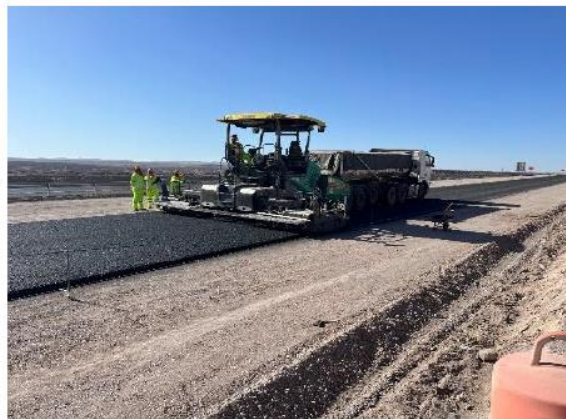
Foto N° 04 Instalación de Bínder Dm 1.000
