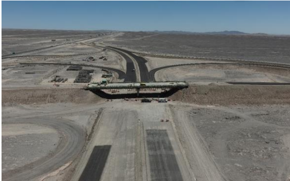
Foto N°01 Enlace Dupont. Sector A
