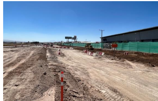
Foto N°04 Construcción de eje 10 sector APIAC. Sector A
