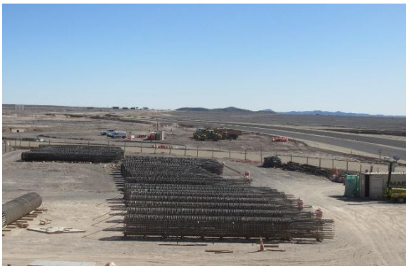
Foto N°05 Enfierradura pilotes puente Yalquincha. Sector B
