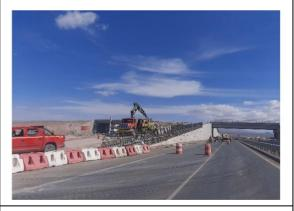
Foto N°05 Demarcación e instalación de tachas Km 100,0
