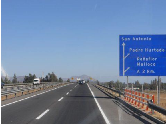
Fase de Construcción (1.9.2.6)
