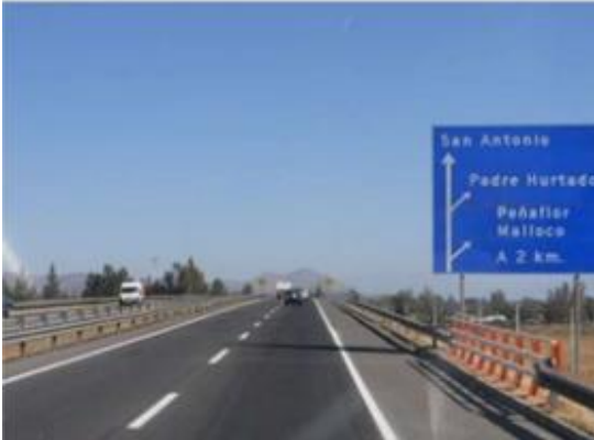
Fase de Construcción (1.9.2.6)
