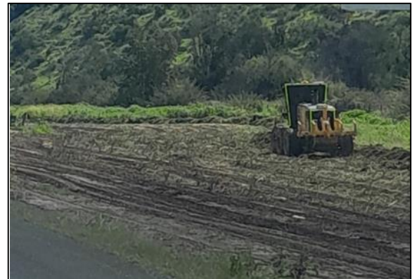
Foto 4 Roce con maquinaria km. 58,800- ascendente
