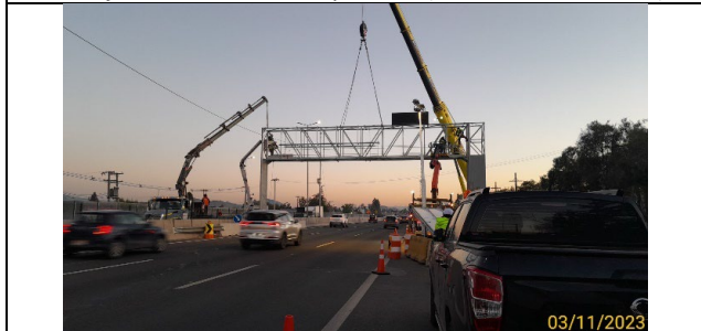
Trabajos de instalación de pórticos (km 27,2 – Malloco 2)
