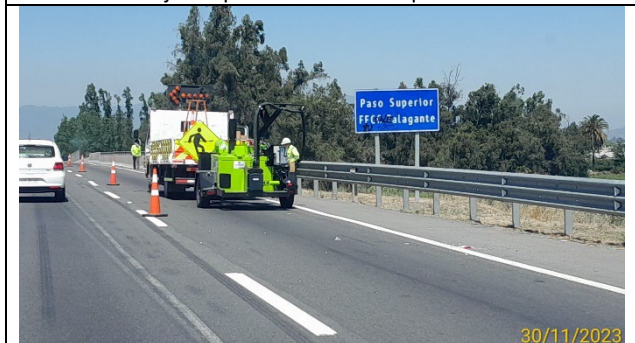
Trabajos de conservación de pavimentos – Sello de grietas
