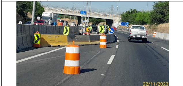
Trabajos de instalación de pórticos (km 8,1 – Vespucio)
