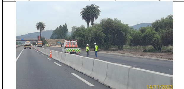
COAVECS sector Chilligüe (km 54,0)
