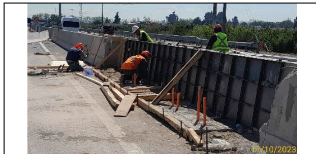
Trabajos de instalación de pórticos (km 32,8 – Talagante)
