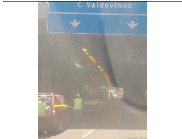
Mantenimiento luminarias km. 10,100- descendente
