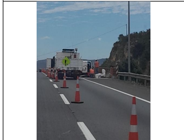
Reparación de defensas en mediana km.69,650
