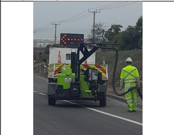
Sello de grietas en sector de Pista de Emergencia- km. 5,250
