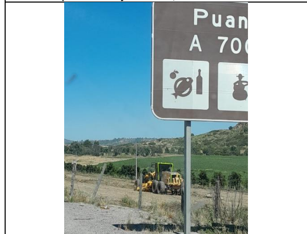
Roce de Faja con maquinaria km. 79,500- ascendente
