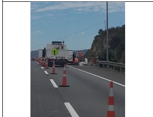
Reparación de defensas en mediana km.69,650
