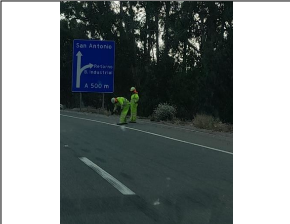
Instalación de tachas- NAPSA- km.3,600- Asc.
