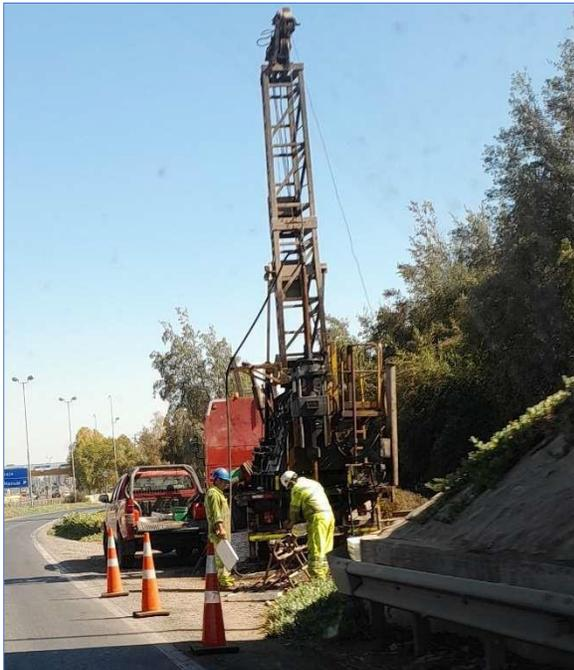
Imagen N°1: Sondaje en km 65,700, ascendente, Enlace Melipilla
