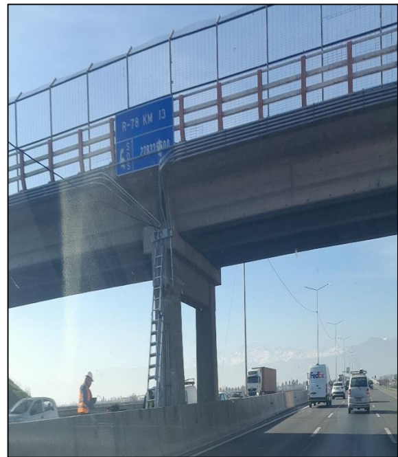
Foto 7: reparación sistema iluminación mediana km 13,450- terceras pistas
