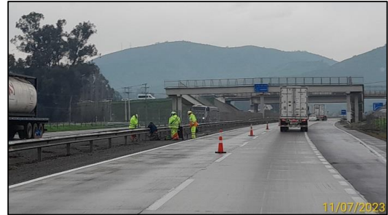
Foto 6: Trabajos Reposición Vallas Peatonales, en mediana, día 27.07.23
