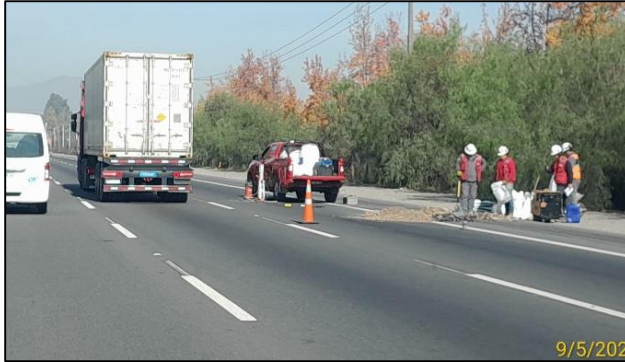
Imagen 5: En el km. 30,5 (aprox.) se realizan tareas de despeje y limpieza de faja, calzada derecha
